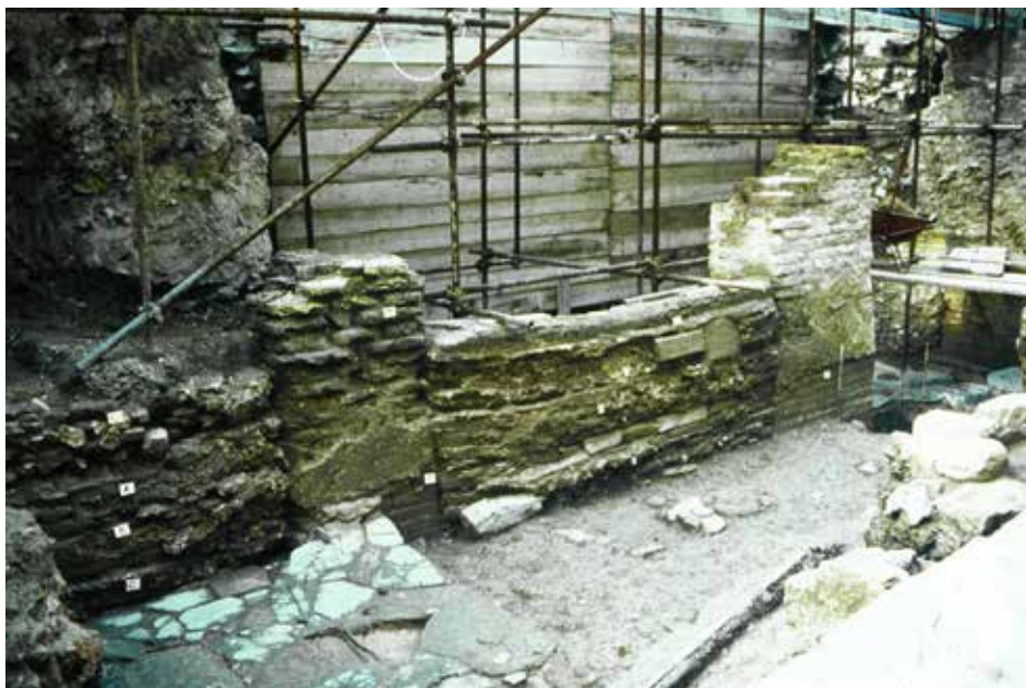
Figura 5. Settore sud dello scavo Strutture del Portico. In evidenza la muratura in ‘opera caotica’ che chiude il Portico verso est. Il muro era addossato ‘contro terra’ al rialzamento della via in epoca giustiniana.
