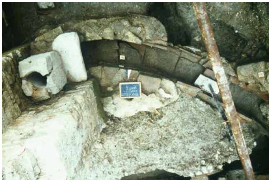
Figura 13. Vano seminterrato all'interno dell'ex Portico traiano, ristrutturato in fase giustiniana. Veduta del blocco di calcare di riutilizzo con foro passante e 'pedana' in lastra di calcare bianco del Conero. Il tutto è collegato a canaletta che scarica nella attigua fognatura sottostante la via est-ovest che conduce alla banchina. Probabile Latrina. L'intervento si data probabilmente nel VII secolo d.C.
