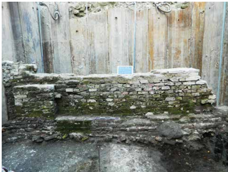
Figura 3. Piazza Anita Garibaldi (RA). Muratura con andamento nord-sud, relativa all'edificio di probabile funzione culturale
