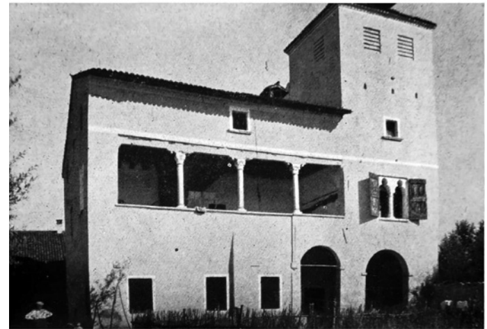
Figura 12 Località Cattane (Vicenza), Villa Loschi, Zileri Dal Verme: fasi dei cambiamenti e restauri dell'edificio dagli anni Trenta del Novecento ad oggi. Da Istituto Regionale Ville Venete
