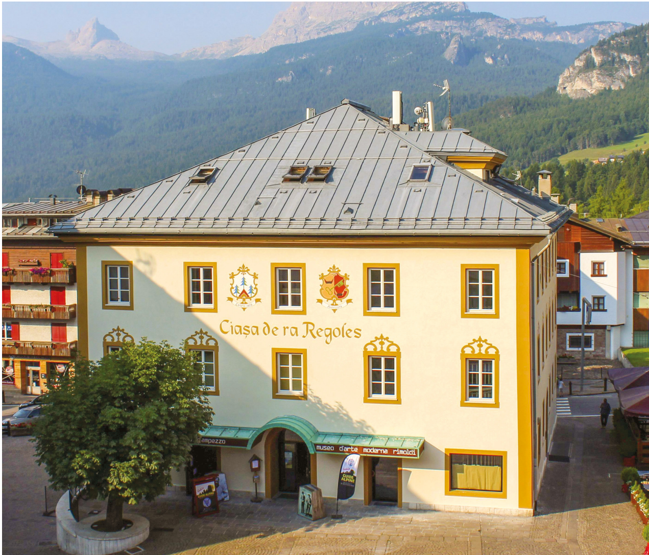
Figura 1 La Ciasa de ra Regoles a Cortina d'Ampezzo dopo le ultime modifiche all'edificio con l'allestimento del Museo Rimoldi su tre piani, nonché con la sede delle Guide Alpine in una parte del pianterreno, 2010 ca.
