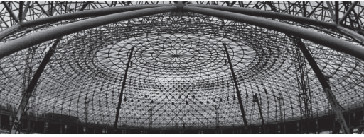
Figura 2 La cúpula de Vitoria. Imagen donde se aprecia «eso que parecen moscas», es decir «los obreros que están ‘cosiendo’ el casquete superior con la parte de abajo de la estructura» (correo del 21 de junio de 2021). Fotografía: gentileza del autor
