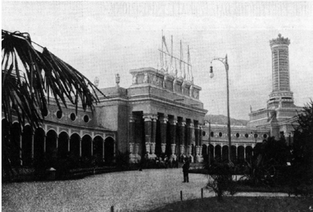
Figura 8. La grande esedra all'ingresso della prima Esposizione voltiana (Como 1899)
