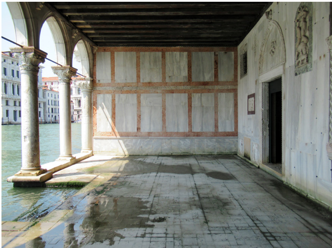
Figura 5 Il rivestimento parietale del porticato
