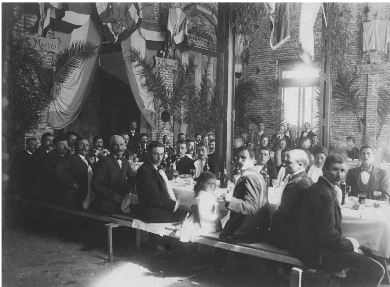
Figura 1. Almuerzo en la obra del Teatro Municipal con motivo del techado del edificio. 1907. Fotografía sobre cartón, 30 × 38cm. San Nicolás de los Arroyos, Museo y Archivo Municipal Gregorio Santiago Chervo, Fototeca Municipal, inv. 3342. ©Museo y Archivo Municipal Don Gregorio Santiago Chervo
