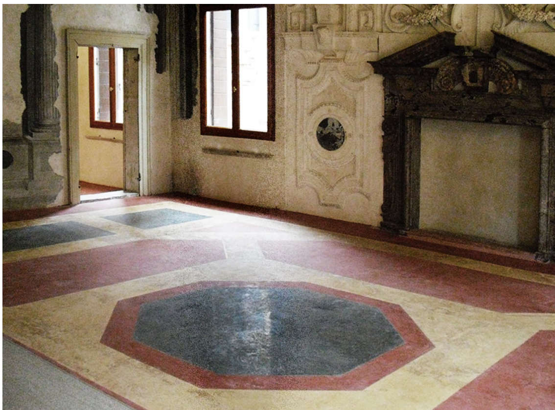
Figura 1 Pavimento a pastellone della Sala del Camino di Palazzo Grimani
