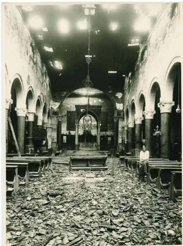
Figura 4. Duomo di Pola, interno dopo un incendio. Archivio Fototeca A. Morassi
