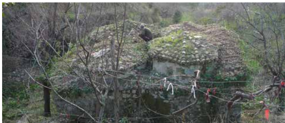
Figura 11. L'edificio dopo le operazioni di taglio della vegetazione infestante che lo nascondeva completamente
