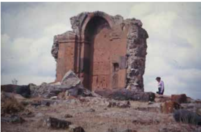
Figura 3. Marmashen, Armenia. In questa immagine si può notare chiaramente la composizione del paramento murario 'a sacco'
