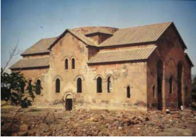
Figura 1. La chiesa di Arudj, Armenia. Si nota che il crollo della cupola ha garantito la sopravvivenza della struttura, nonché le nicchie 'scavate' onde alleggerirla
