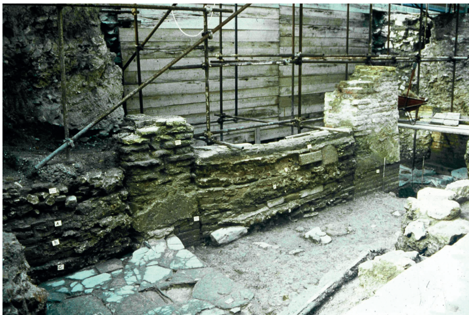
Figura 5. Settore sud dello scavo Strutture del Portico. In evidenza la muratura in ‘opera caotica’ che chiude il Portico verso est. Il muro era addossato ‘contro terra’ al rialzamento della via in epoca giustiniana.
