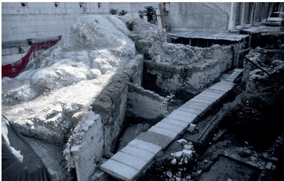
Figura 2. Ancora una veduta del Settore sud dello scavo, visto da nord-ovest, dalla quale appare evidente la difficoltà dell'intervento archeologico, considerata la complessità delle sovrapposizioni strutturali e dei recenti scassi per l'urbanizzazione dell'area
