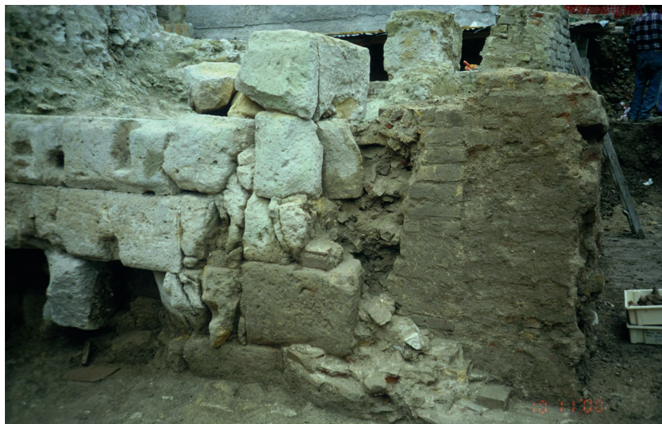
Figura 3. Settore sud dello Scavo. Area Vano 38. Parete nord della cosiddetta 'Torre' In questo dettaglio si può cogliere la complessità delle sovrapposizioni strutturali dell'area. A sinistra si notano i blocchi di tufo della Torre (II secolo a.C.), con fori di riutilizzo (V-VI sec. d.C.). A destra in basso, traccia del muretto in laterizi, in parte sottofondazione dell'angolo della Torre, relativo alla struttura tardo-antica (fine V-prima metà VI d.C.) del cosiddetto Vano 38. Sul retro del muretto si può notare una regolare muratura in laterizi relativa a rifacimenti del tardo II secolo d.C. (edificio con mosaici e affreschi) al quale si appoggia il muro 'a scarpata' in laterizi, forse riferibile alla metà del VI secolo d.C. che risulterebbe tagliare anche il precedente 'muretto' del Vano 38. La faccia a vista del muro risulta distrutta e tagliata da una condotta recente.
