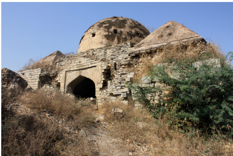
Figura 7. Soffitti lignei, maṇḍapa , Rangini Mahal, XVI sec., Forte, Bidar
