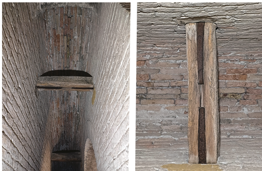
Figura 5 Campanile dei Gesuiti: elementi di collegamento tra le due canne
