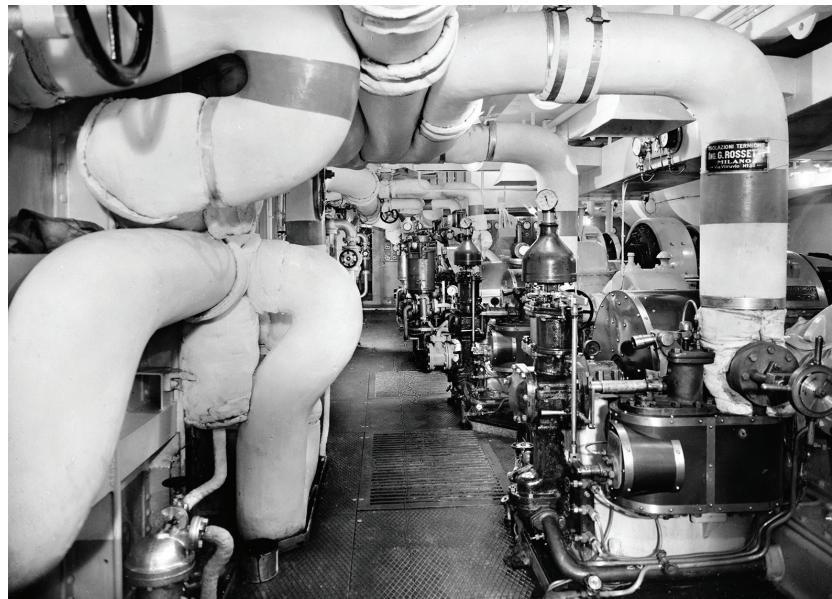
L'apparato motore, costituito principalmente da nove caldaie a nafta per produrre vapore, il quale spinge le due turbine a doppio riduttore per muovere gli assi delle due eliche nella sala macchine (doppio fondo). Nonostante l'evoluzione tecnologica nell'ambito della propulsione navale, il *Conte Biancamano* rimase con macchine a vapore per tutta la sua vita.
