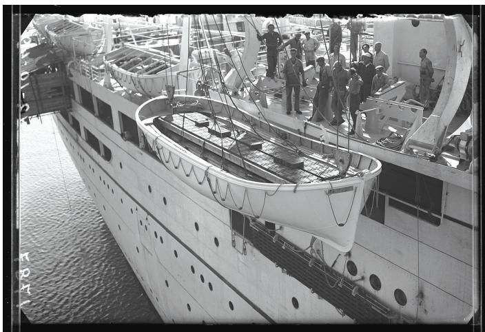
Le maestranze del cantiere progettano e realizzano le nuove lance di salvataggio con relative gru di sollevamento ed effettuano prove di carico e di ammaino in mare. I nuovi sistemi di salvataggio furono progettati per ottemperare all'aggiornamento del 1948 del SOLAS (Safety of life at sea), un accordo internazionale volto alla salvaguardia della vita umana in mare.
