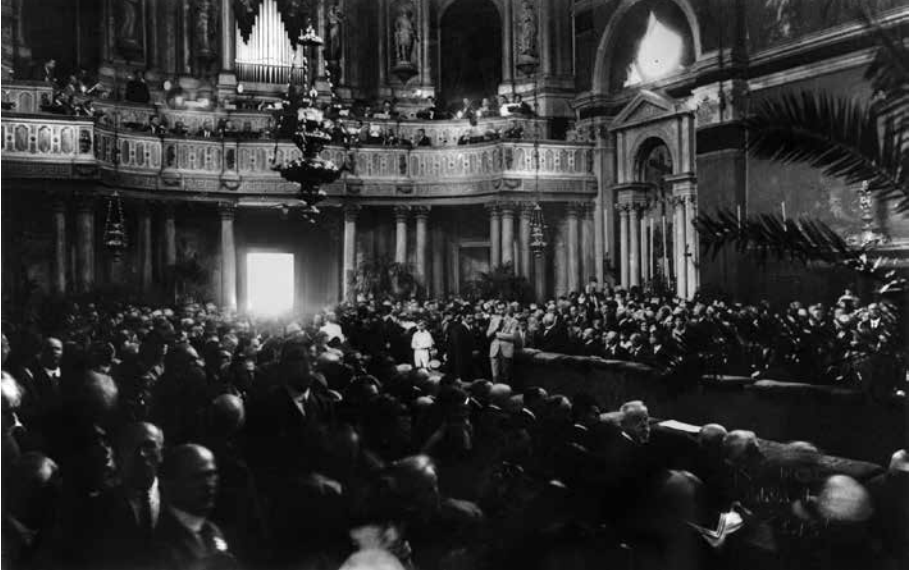
Figura1. Cantoria della Scuola Grande di San Rocco, ultimo montaggio. Venezia, chiesa di San Rocco, 1927
