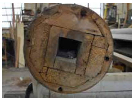
Figura 7. Estremità superiore di una colonna, in sezione
